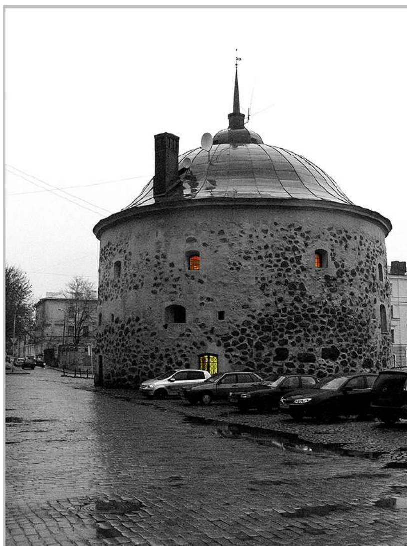
Ил. 1. Выборг. Круглая башня. Фото: © С. С. Аванесов, 2009
