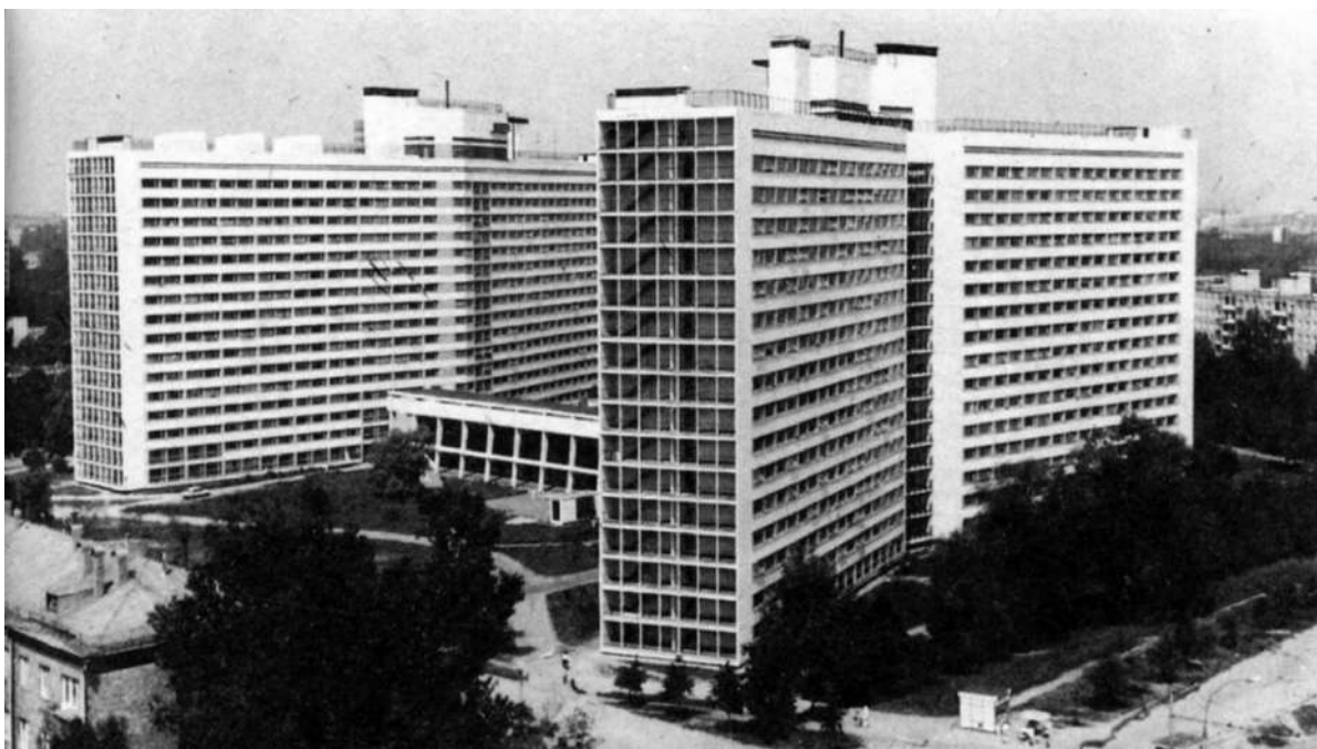
Ил. 1. Дом нового быта. Москва, 1965–1971. Архитекторы: Н. Остерман, А. Петрушкова, И. Канаева, Г. Константиновский, Г. Карлсен. Фото: Д. Есаков, 2015.
