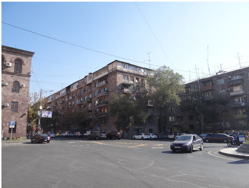
Ил. 6. Нахалстрой в самом сердце Еревана: достроен целый этаж. Не сразу и заметишь... Фото автора. 2021
