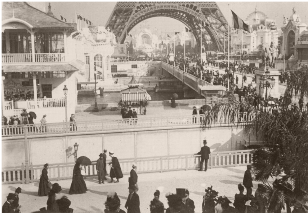
Ил. 4. Мост Йена. Источник: https://clck.ru/qCQFz
