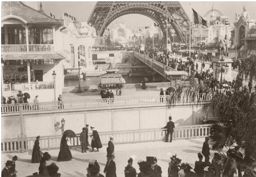
Ил. 4. Мост Йена. Источник: https://clck.ru/qCQFz
